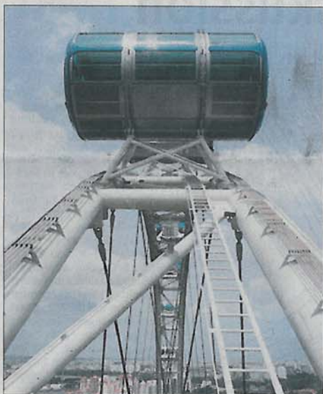
Ein weiteres Leuchtturm-Projekt der Firma Vahle: Die Kabinen des größten Riesenrads der Welt in Singapur, größer als das London Eye, werden mit Vahle-Stromzuführungen gesteuert.
