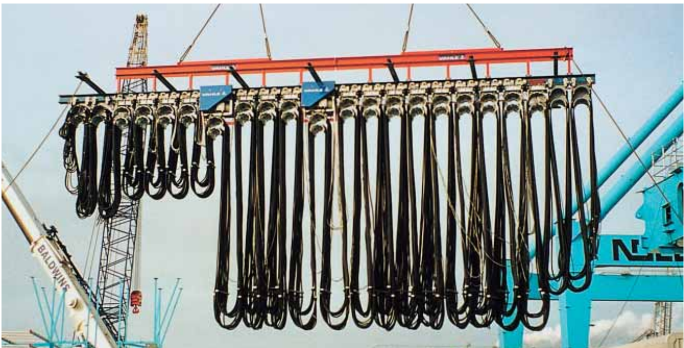
Montaje de un Sistema de Carros portables en el puerto de Rotterdam
