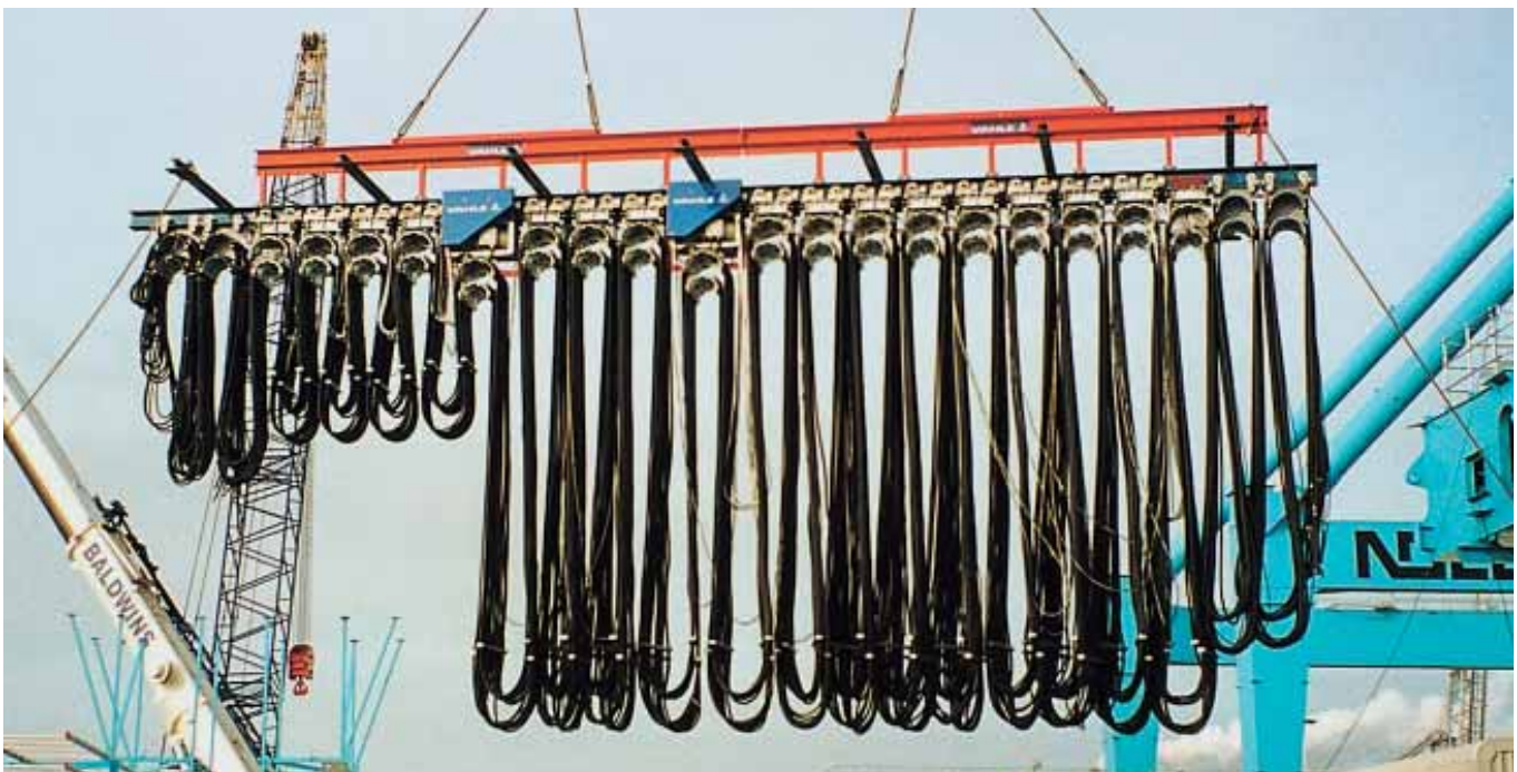
Montaje de un Sistema de Carros portables en el puerto de Rotterdam
